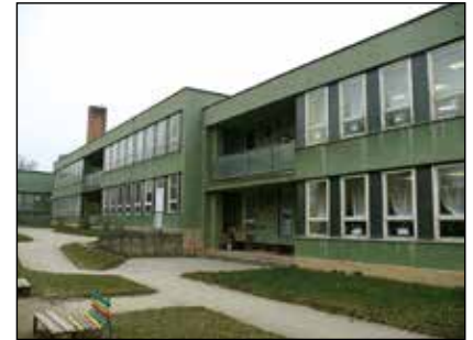
Budova MŠ Měřičkova - stávající stav
