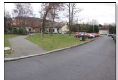
Parkoviště Vl. Pittnerové, stávající stav
