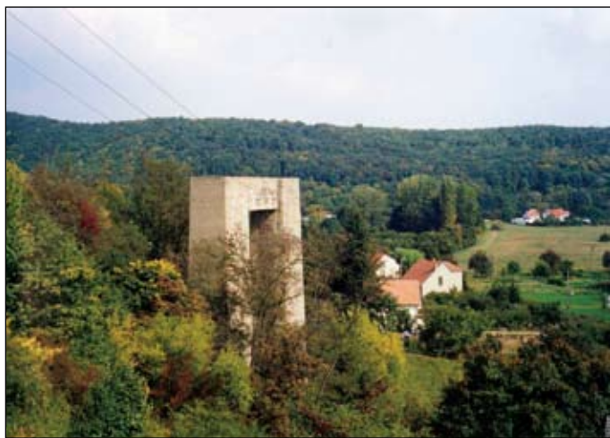
Mostní pilíř u hráze Brněnské přehrady
