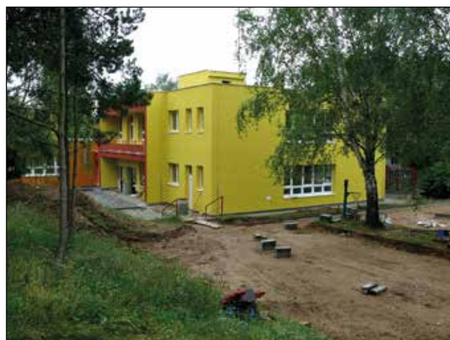
Po zateplení budovy probíhá na MŠ Škrétova rekonstrukce zahrady
