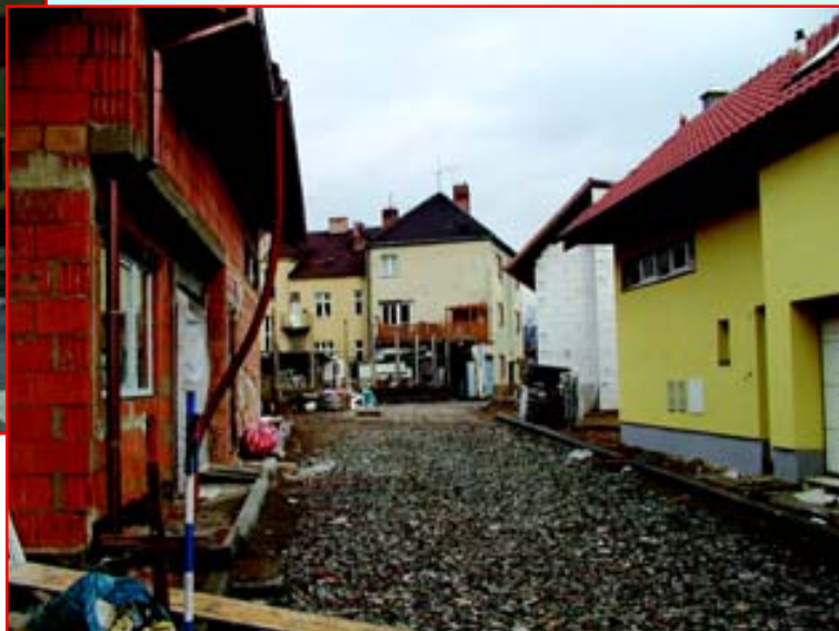
Rozestavěná ulice Járy Cimrmana
