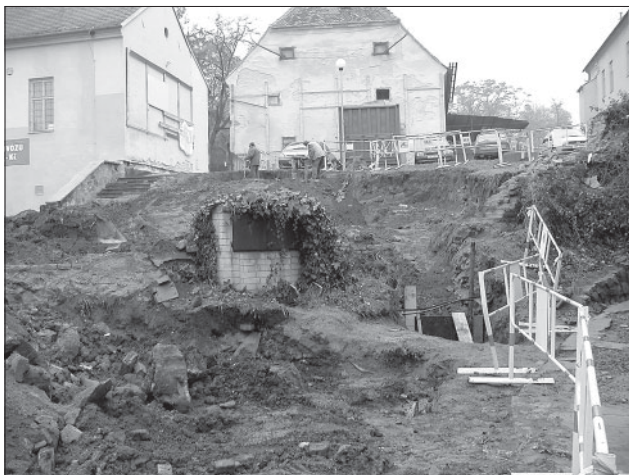
Stav prací k 22. 10. 2002.
