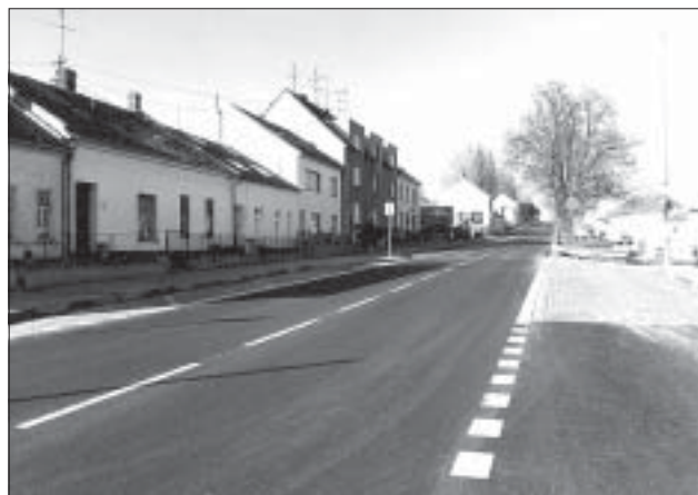
Nově zrekonstruovaná ulice Terezy Novákové.
