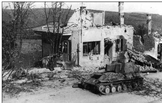
Restaurace „Na Špici“ na Husově ulici (dnes Terezy Novákové) v roce 1945
